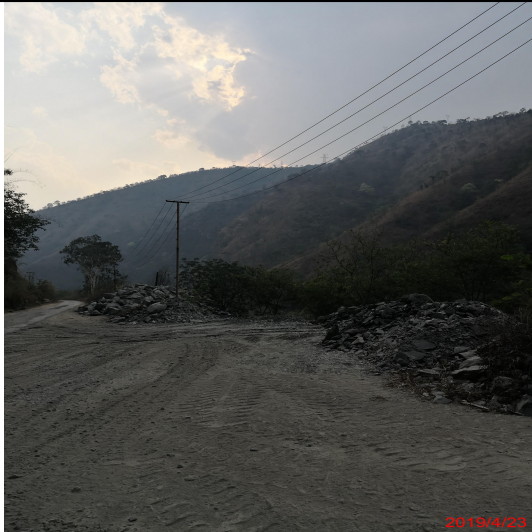
项目原料进场道路
