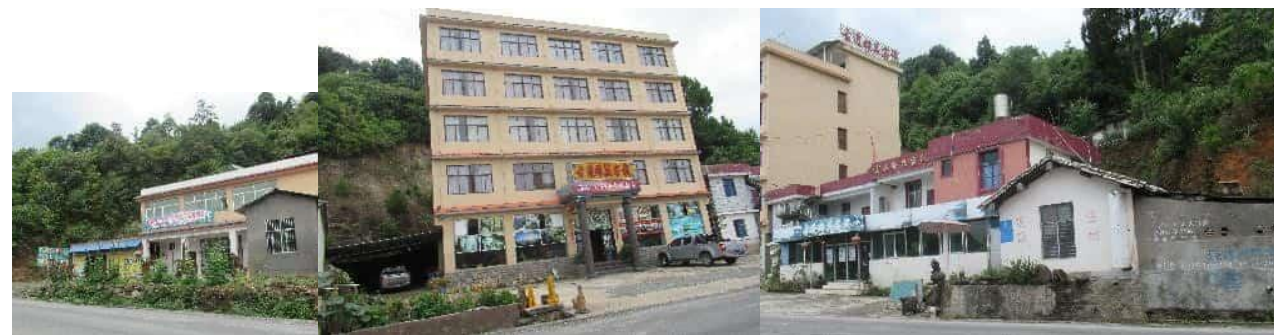
A立面现状照片
