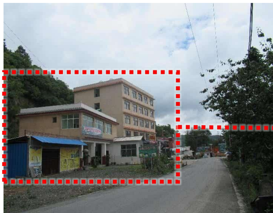
A视角现状照片
