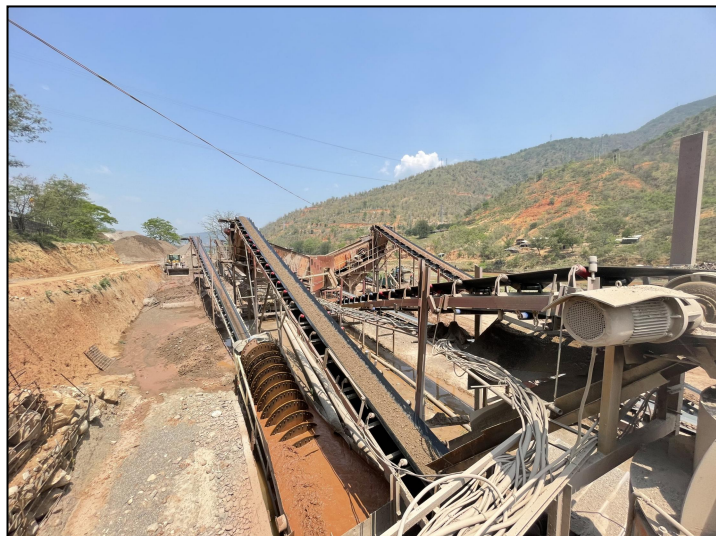
项目区入口现状
