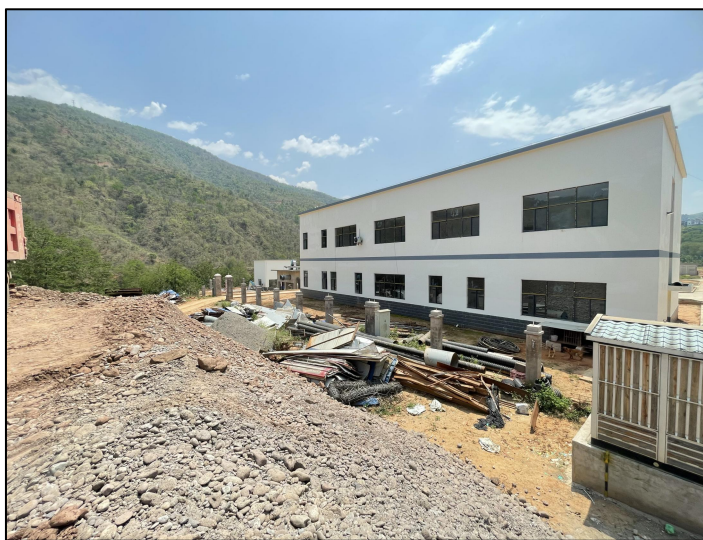
东侧戛洒镇污水处理厂
