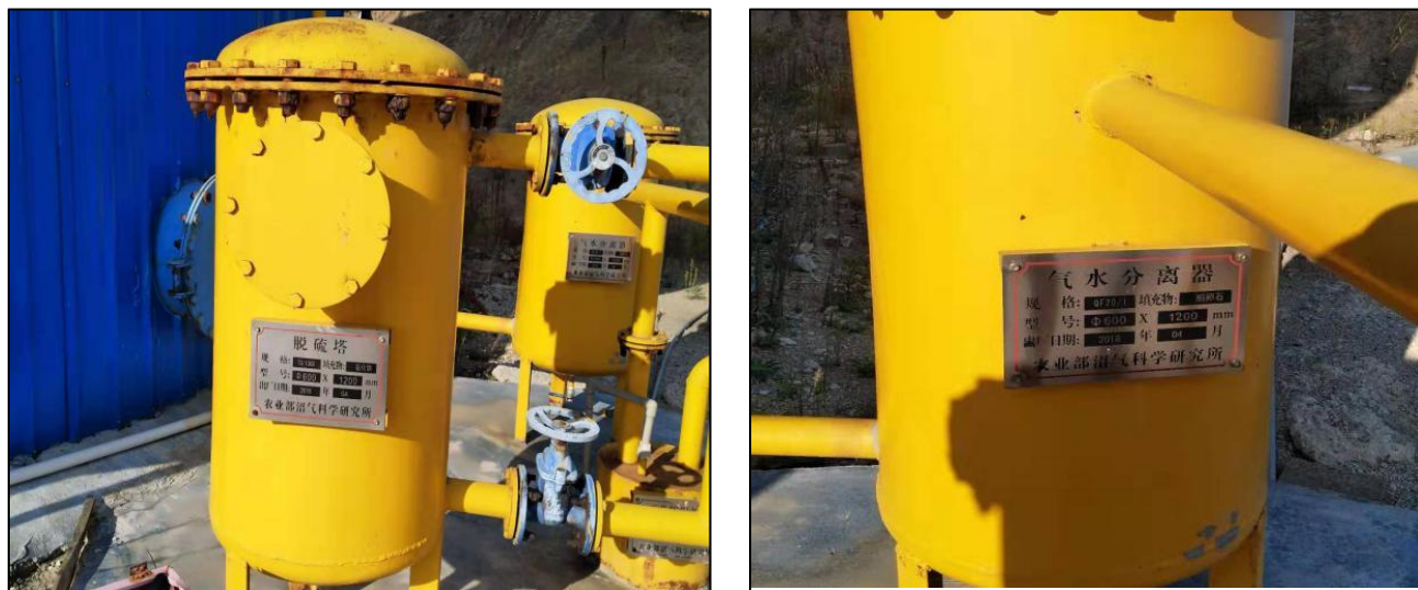
图 6.2-1 沼气脱硫脱水实物示例图
