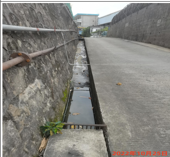
厂区内截排水沟
