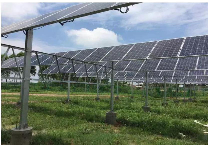
图 2-3 固定式安装运行方式
