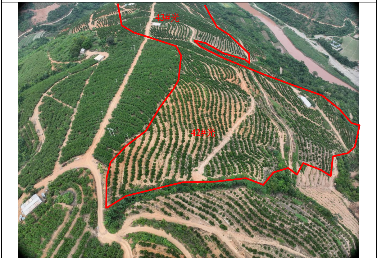
42#、43#光伏阵列现状（2024年9月）
