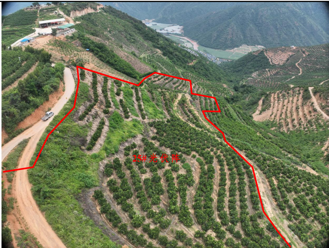
25#光伏阵列现状（2024年9月）
