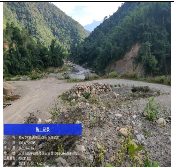
项目南面现状
