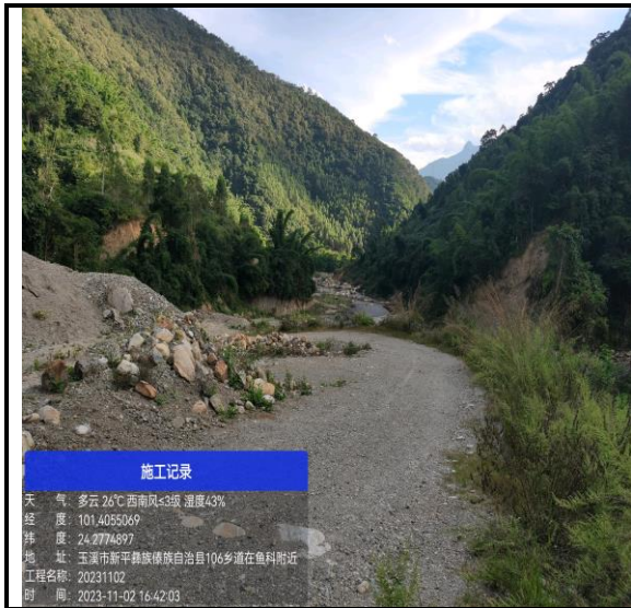
项目南面现状
